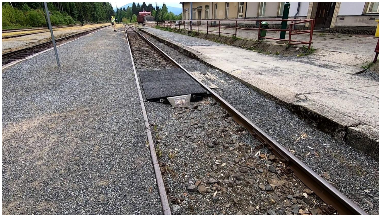
Obr. č.2: Přejech na nástupiště – pohled po směru staničení
